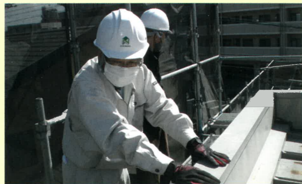
T様邸に足場を架けて外壁検査をしています。プルプル(-_-;)している訳ではありませんよ！
